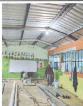
Foto 3: Instalación de energía eléctrica.
