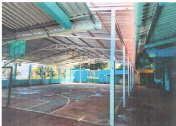
Foto 1: Estructura de techo
