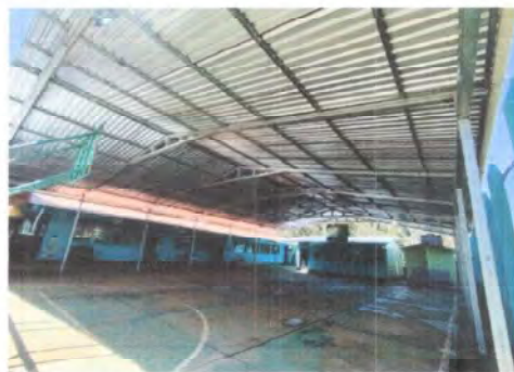
Foto 2: Cubierta de lamina
