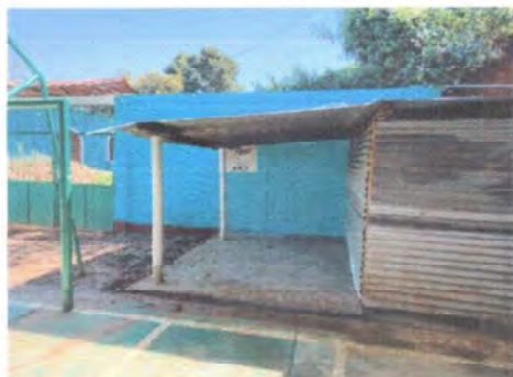
Foto 1: Trabajo extra, mejoramiento de patio de bodega.
